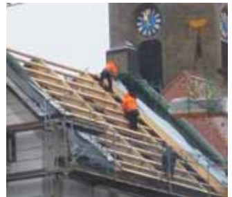
Das Bild zeigt die Arbeiten am Tag vor dem Richtfest.
