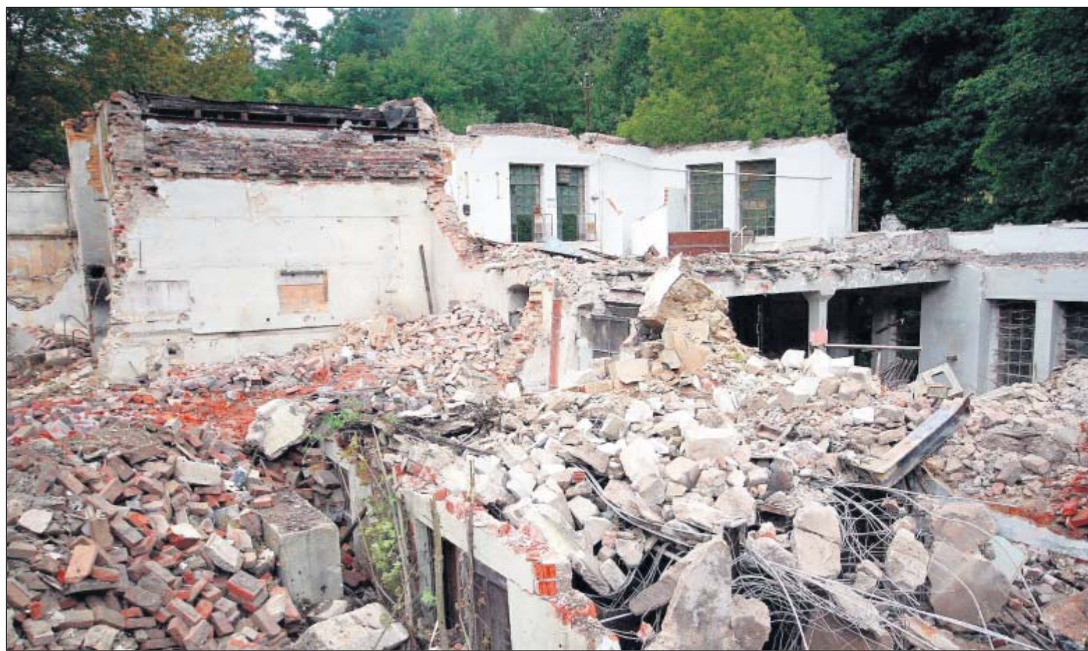
Vom ehemaligen Presswerk in Elisenfels sind nur noch Trümmer zu sehen. Bis Ende des Jahres soll das Werk komplett abgetragen werden. Fotos: Bäumler
